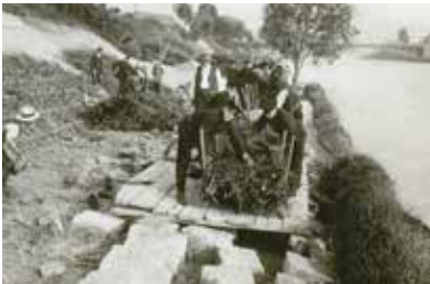
Ufersicherung am Lech, 1912
